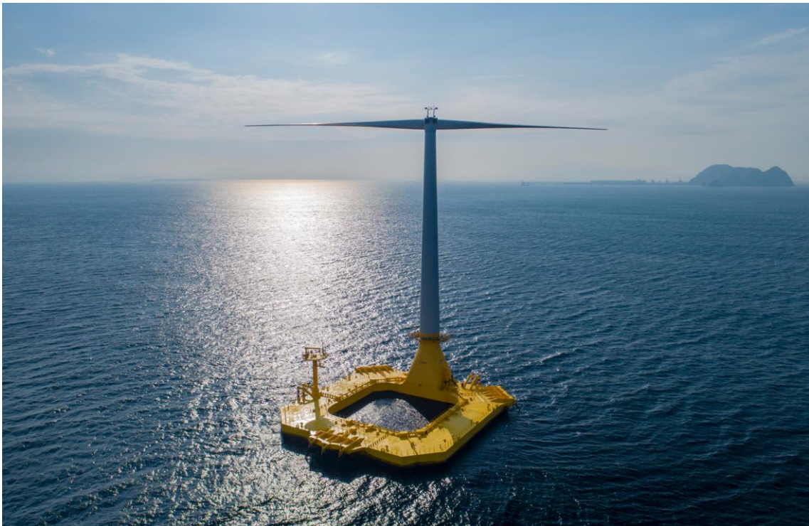
「響灘沖に浮かぶバージ型浮体式洋上風力発電所」
