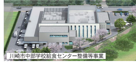
川崎市中部学校給食センター整備等事業
